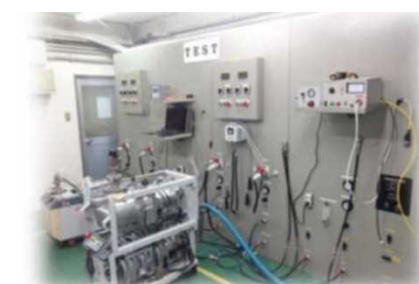
真空事業部内 ポンプ修理工場設備
