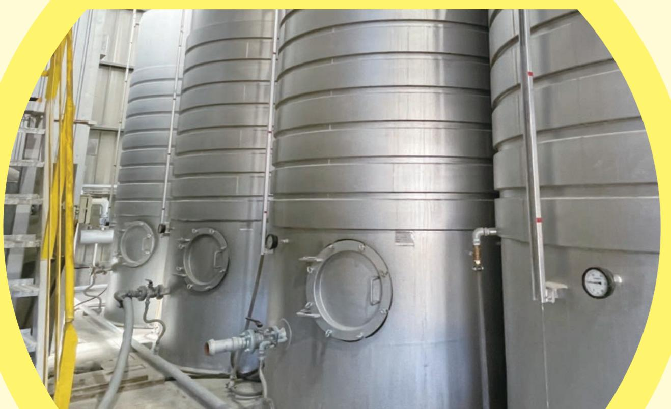
焼酎廃液と蒸したサツマイモなどを投入し発酵させる
